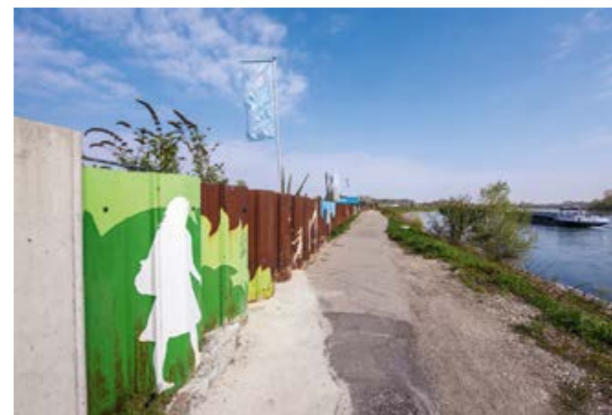
Bis zur Fertigstellung des Quartiers und der Rheinpromenade schützt eine bemalte Spundwand vor Hochwasser.
