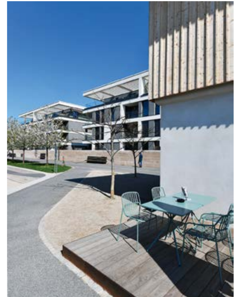
Auf Terrassen, Loggien und Balkonen lässt sich das Leben in der Passivhausssiedlung genießen.
